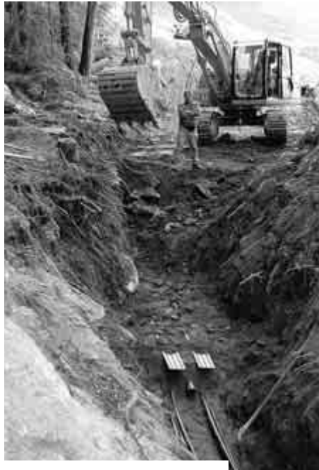
Verlegung der 20-kV-Kabelleitung Moos – St. Leonhard
