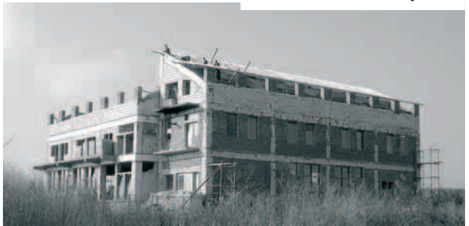
Rohbau der neuen Sozialstation in Iassy
