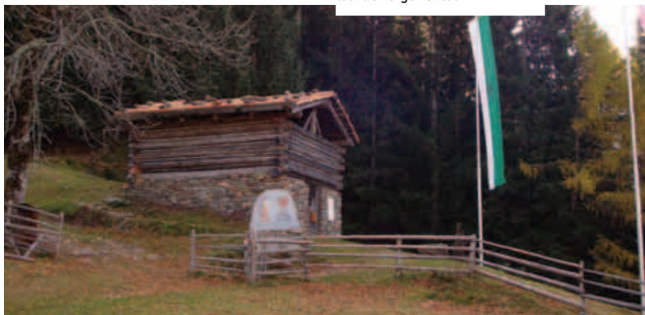
Das Dach der Pfandler-Alm-Hütte wurde hergerichtet
