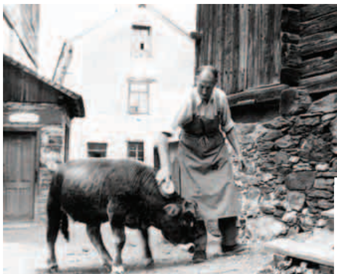
Ein eigenes Postamt (Zubau links) gab es in Platt in den Jahren 1937 bis 1958. Im Bildhintergrund das frühere Platter Schulhaus Foto: Arnold Rinner
