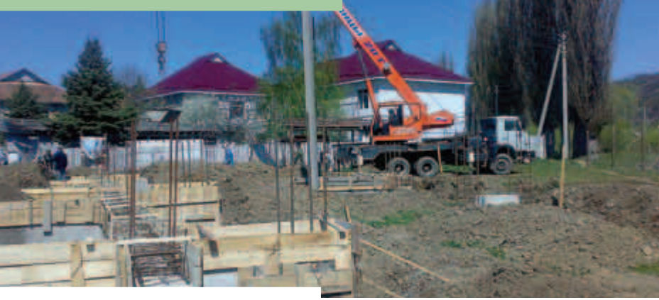
Bau des sozialen Zentrums in Ciuciuleni
