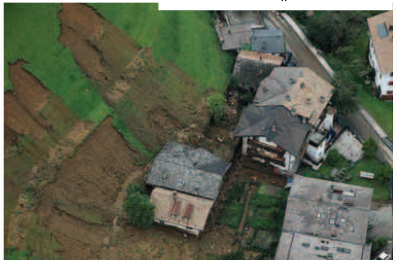
Unwetterschäden im Schaffeld
