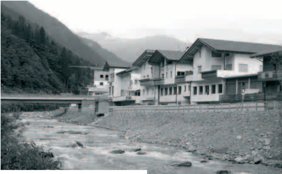
Der neue Damm bei der Gewerbezone Schweinsteg
