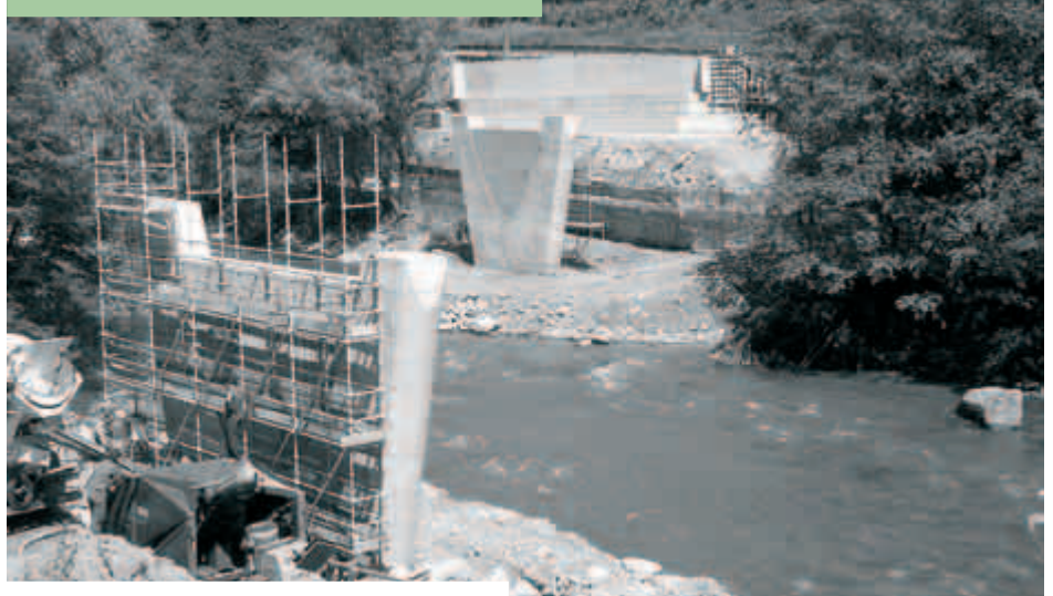
Bau der neuen Gerlosbrücke
