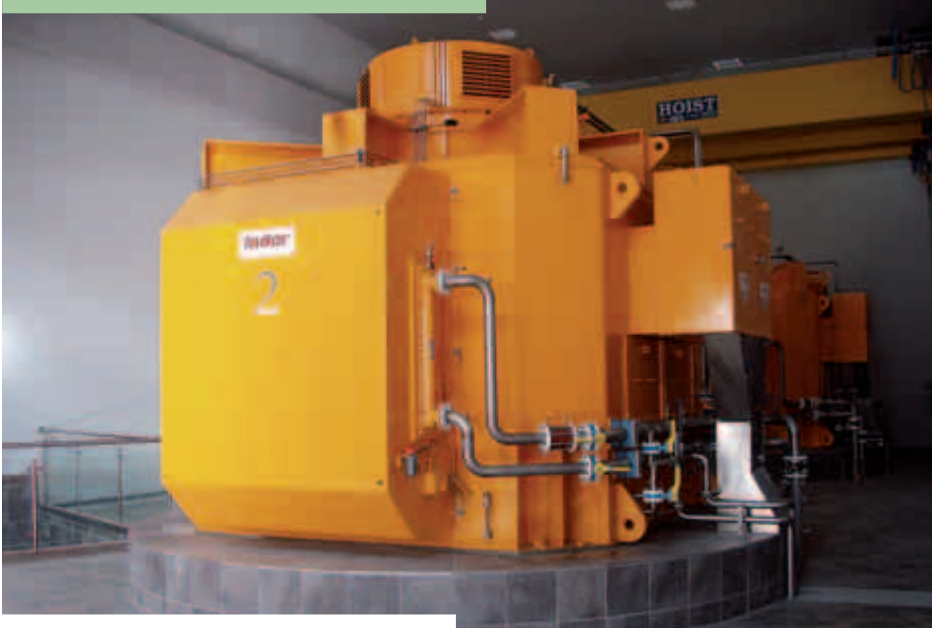
Die Generatoren erzeugen Warmwasser
