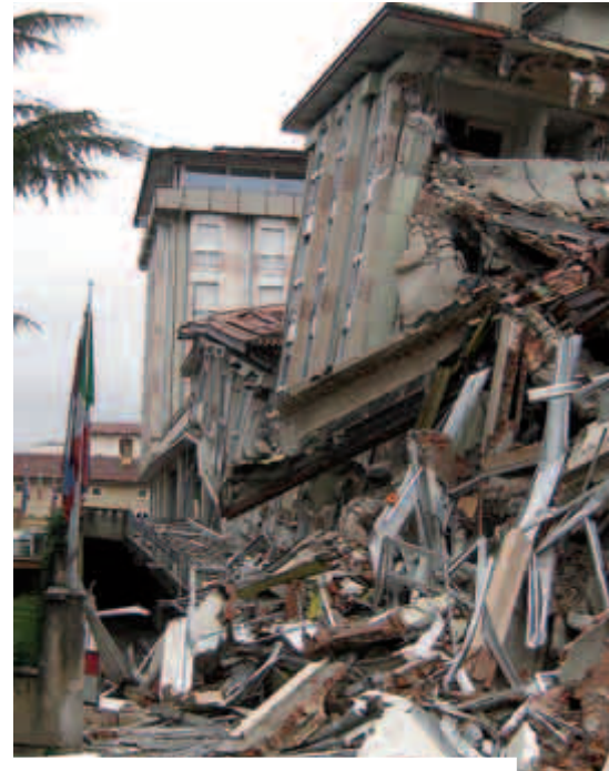
Zerstörte Gebäude im Erdbebengebiet
